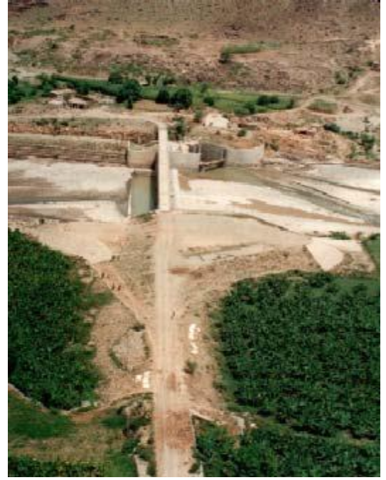
صورة (٨) أحد الحواجز التحويلية بمشروع وادي رمع م /الحديدة
