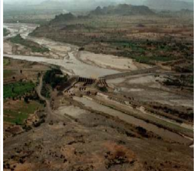
صورة(٦) الحاجز التحويلي لمشروع وادي مور م /الحديدة صورة (٧) إحدى قنوات الري بمشروع وادي مور م /الحديدة
